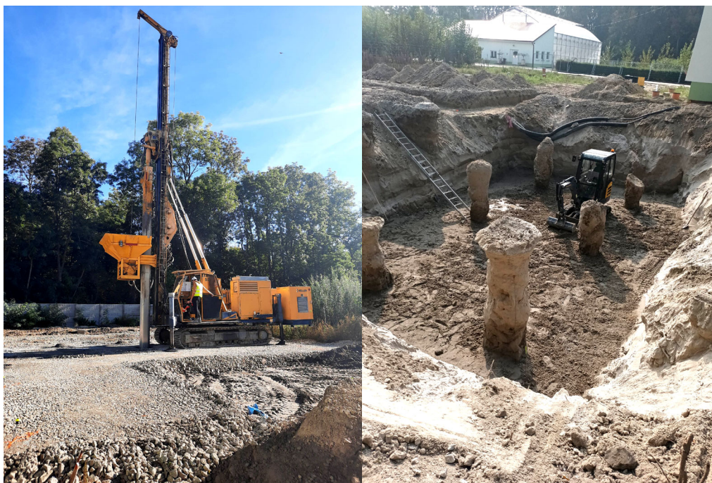
Obrázok 6. Vrtná súprava a odhalené vibrostĺpy pri budovaní podzemného priestoru haly
