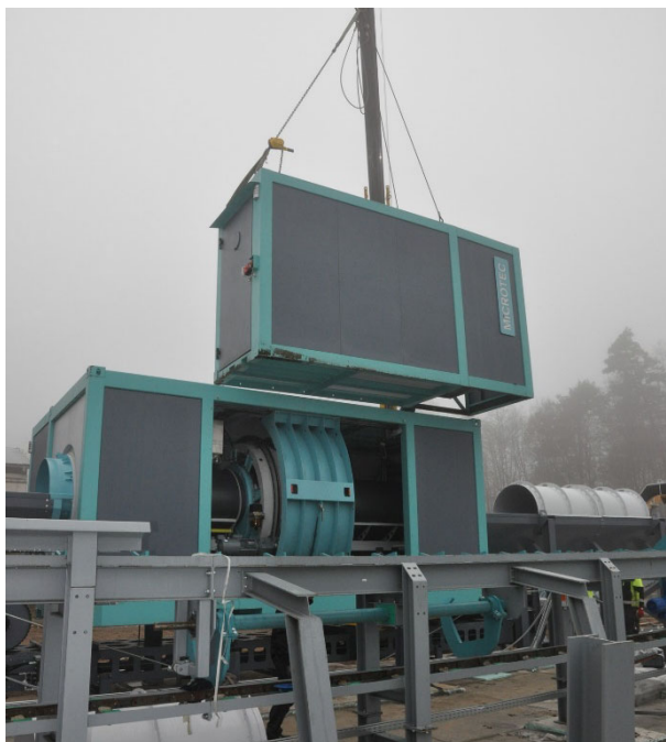
Obrázok 1. Inštalácia 3D CT skenera do skenovacej linky
