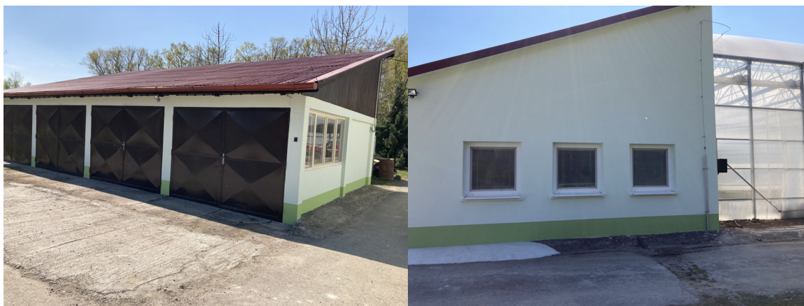
Obrázok 8. Zrekonštruované obslužné budovy
